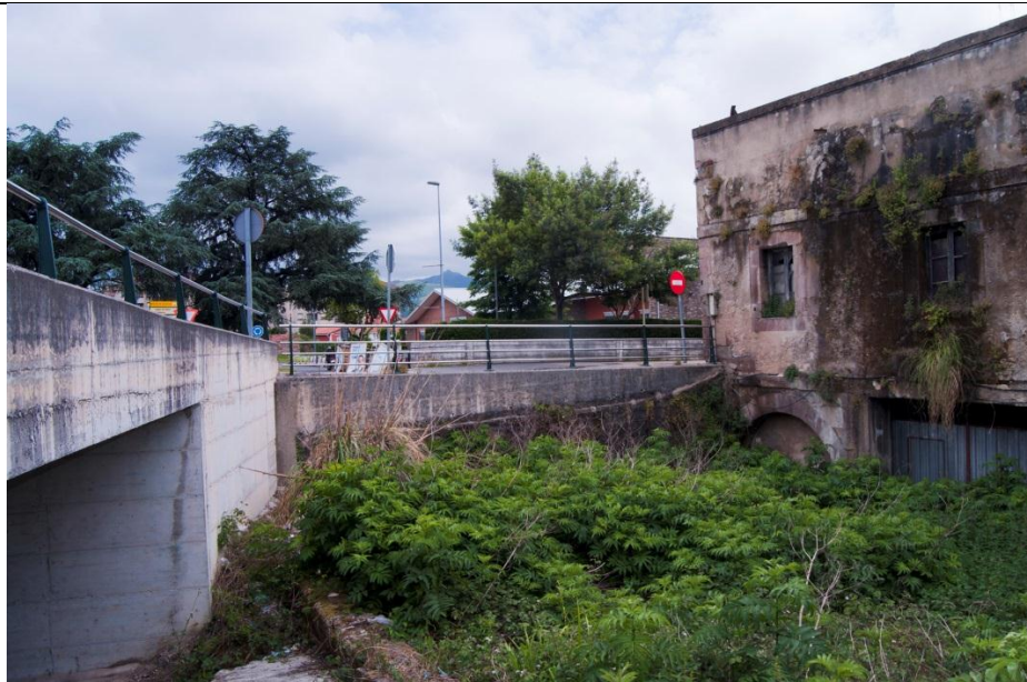
30 T 413557 4797272. Vista de la fachada norte y los arcos de salida del agua.
